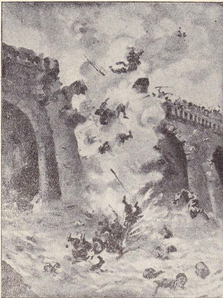
Destruction d'un pont sur la Marne par les Allemands
